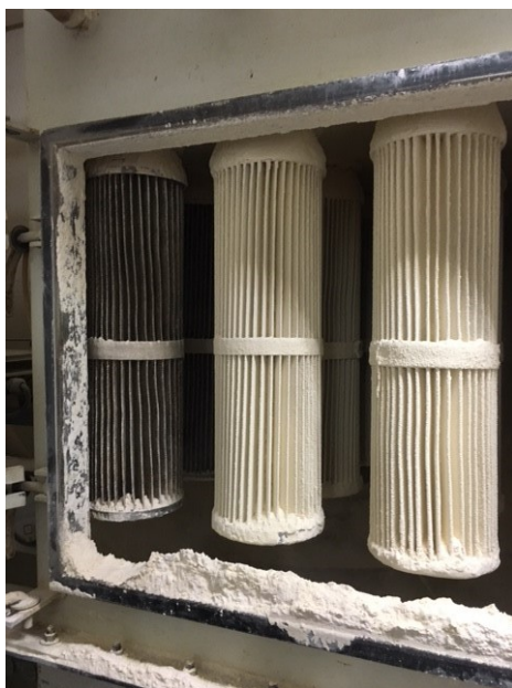
Filter links in beeld na het pulsen. Duidelijk beter ontstofst na het pulsen
